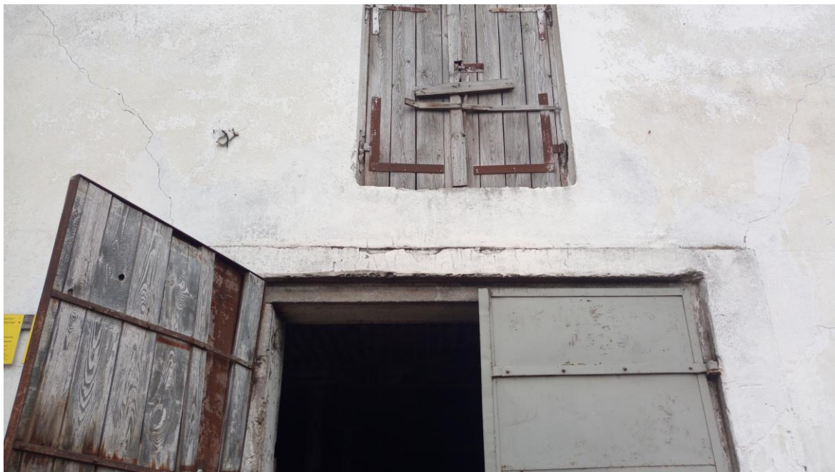
Zdj. 5. Zarysowania nad drzwiami od strony wschodniej.
