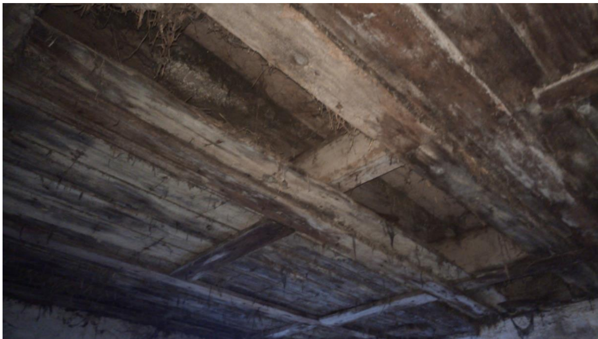
Zdj. 3. Korozja i zawilgocenie stropu drewnianego.
