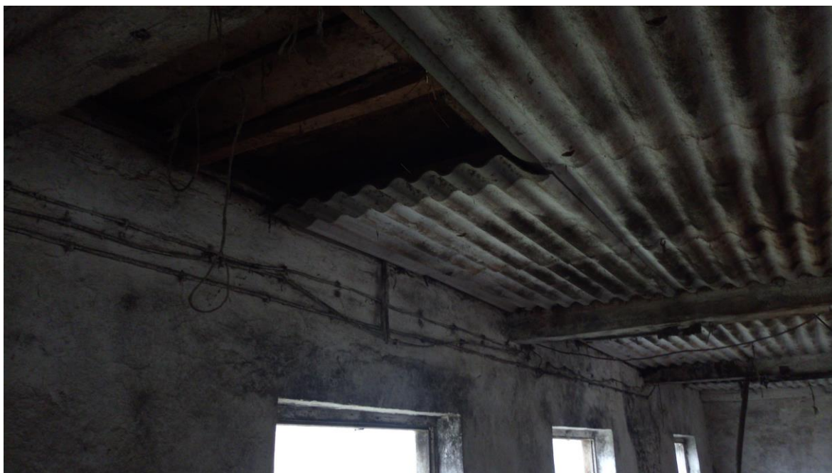
Zdj. 2. Ubytki w podbitce stropu drewnianego.
