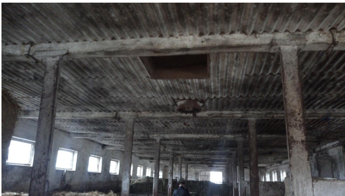
Zdj. 4. Korozja konstrukcji wsporczej stropu drewnianego.
